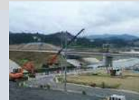
高台に囲まれた防災庁舎
